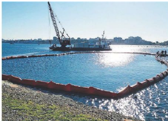
MAR PICCOLO Le operazioni di bonifica
